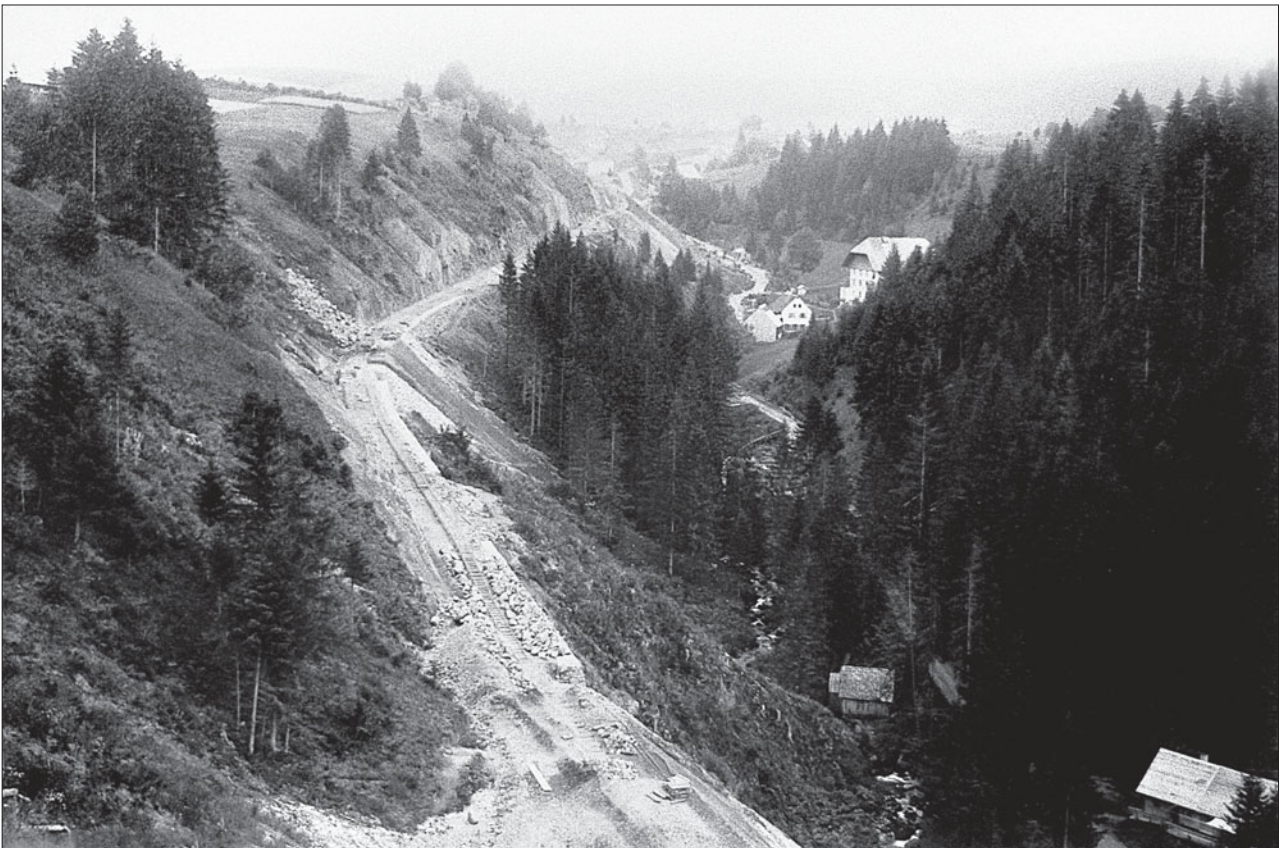
Baustelle der Höllentalbahn im oberen Bereich des Löffeltals. Die Aufnahme entstand 1885 vom bergseitigen Portal des 82 m langen Löffeltaltunnels aus, im Hintergrund sind die ersten Häuser von Hinterzarten sowie die zum Bahnhof führende Kurve zu sehen.
